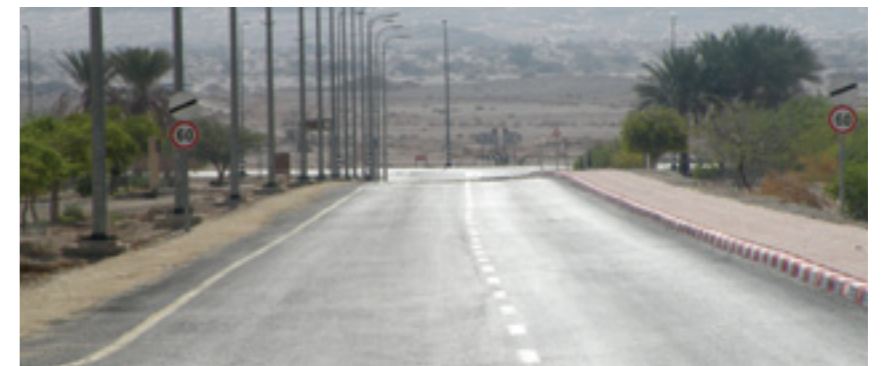
הרחבת כביש הגישה בספיר
